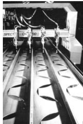
Découpe laser d'âmes optimisées pour de futures poutres métalliques reconstituées soudées. In. Construire en acier , H. C. Schulitz, W. Sobek & K. J. Habermann, Presses polytechniques et universitaires romandes, 2003.
